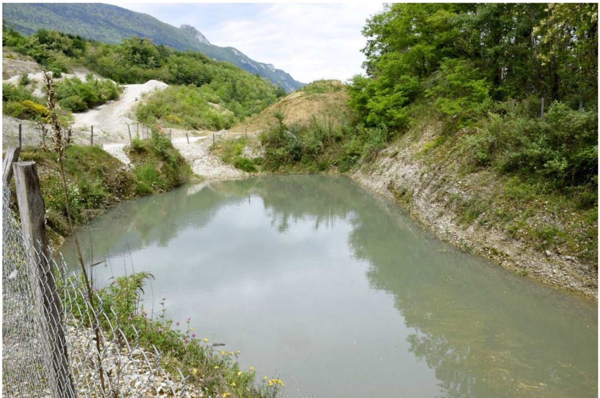
Photographie 6 : Bassin d'infiltration
